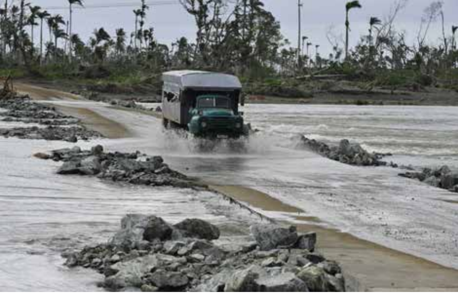
Behelfsbrücke nach Hurrikan Matthew in der Nähe von Barracoa/Kuba. Foto: © Jörg Schaaber
